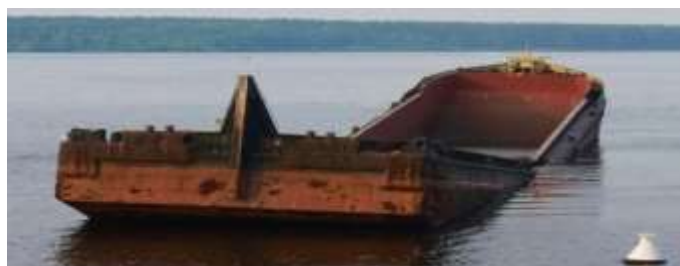
Рис. 11. Перелом баржи пр.1787У при прогибе корпуса
