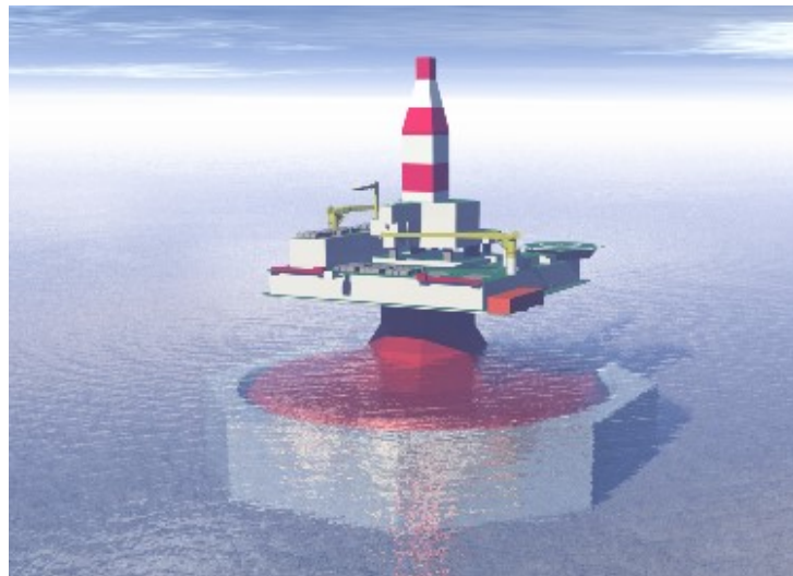
Рис. 8. Общий вид комбинированной буровой установки
