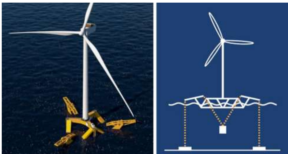
Рис. 8. Модульная плавучая ветряная платформа Gazelle (а – фото, б – 3D-визуализация) [13]
