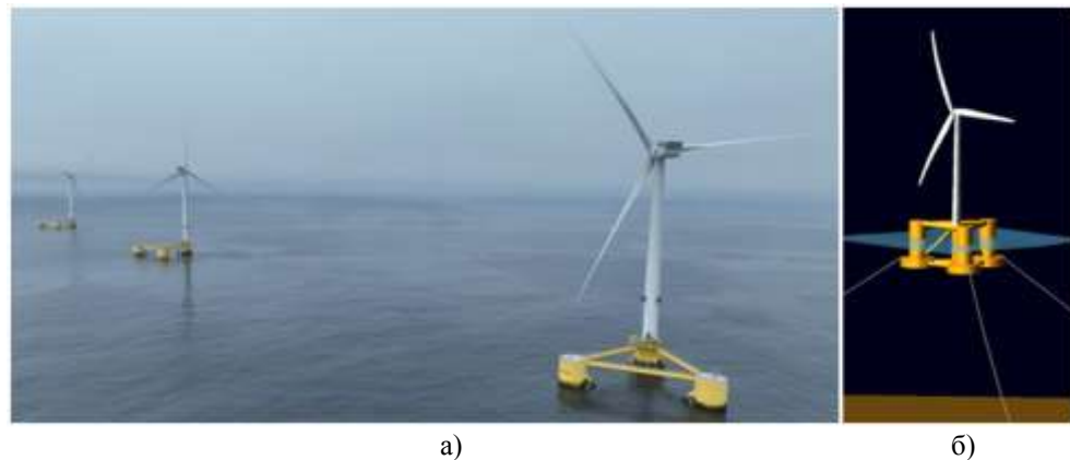
Рис. 5. Полупогружная плавучая морская ветряная электростанция WindFloat Atlantic (а – фото, б – 3D-визуализация) [8]
