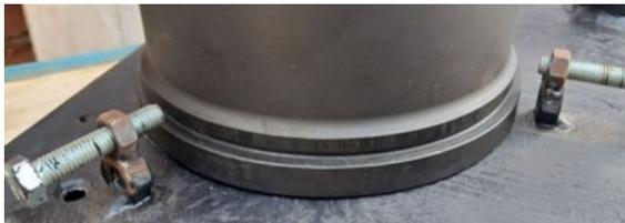
Рис. 12. Установка центрирующих и фиксирующих болтов
