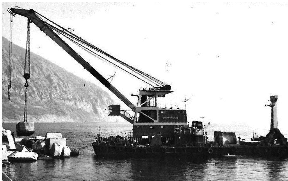
Рис. 1. Работа плавкрана «Черноморец» с массивом 100 тонн на мелководье
