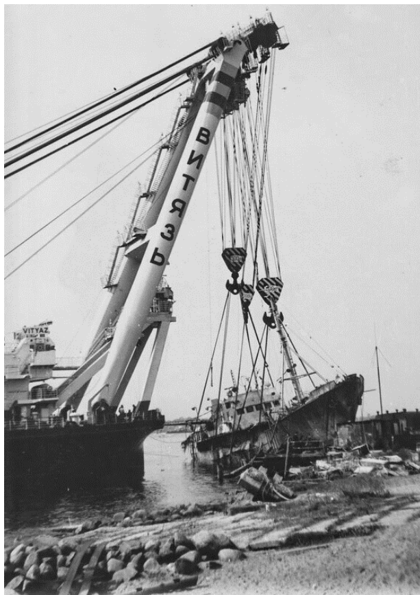
Рис. 8. Сдаточные испытания плавкрана «Витязь» грузоподъемностью 1000 тонн при судоподъеме
