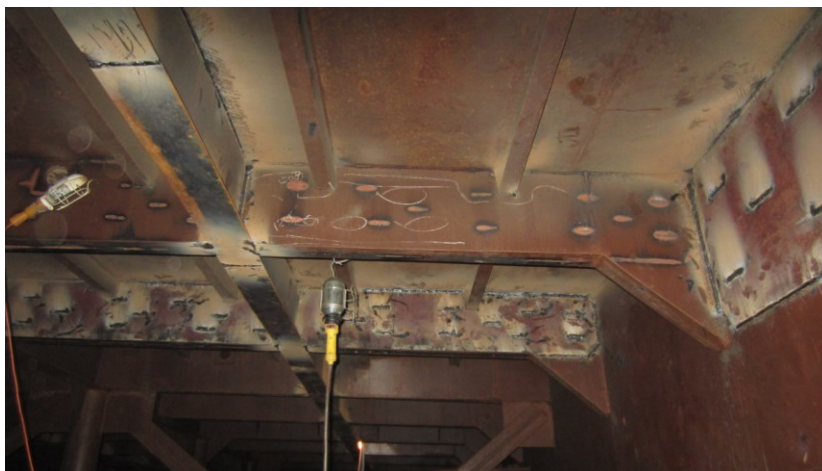
Рис. 1 Фотоизображение реализации подкрепления стенок рамных балок и верхних поясьев переборок листовыми накладными элементами по проекту СКС13.Р-56
