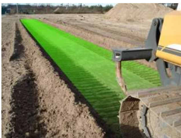
Рис. 4. Результат работы бульдозера с применением СУСТ Торсop 3D ГНСС
