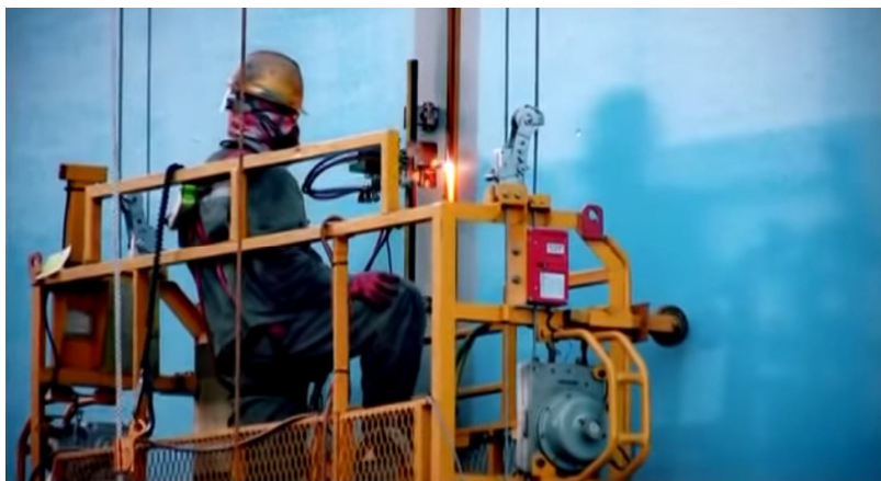
Рис. 1. Механизированная сварочная каретка для выполнения вертикальных сварных швов
