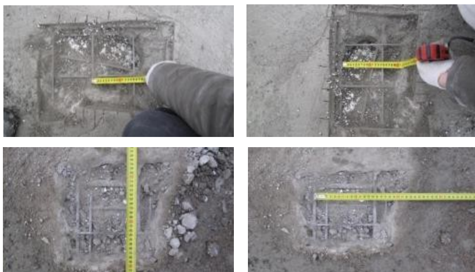
Рис. 4. Обследование схемы армирования причальных понтонов
